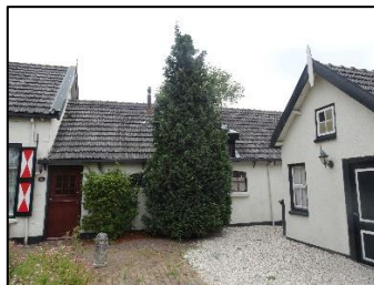
Figuur 4. Zicht op de voorzijde van de woning en de zijkant van een schuur (kijkrichting vanuit het westen).
