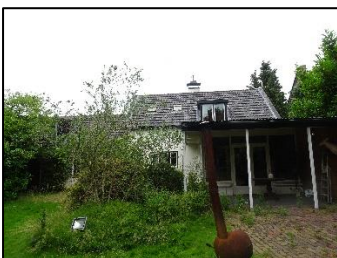
Figuur 6. Zicht op de achterkant van de woning met de overkapping (kijkrichting vanuit het oosten).
